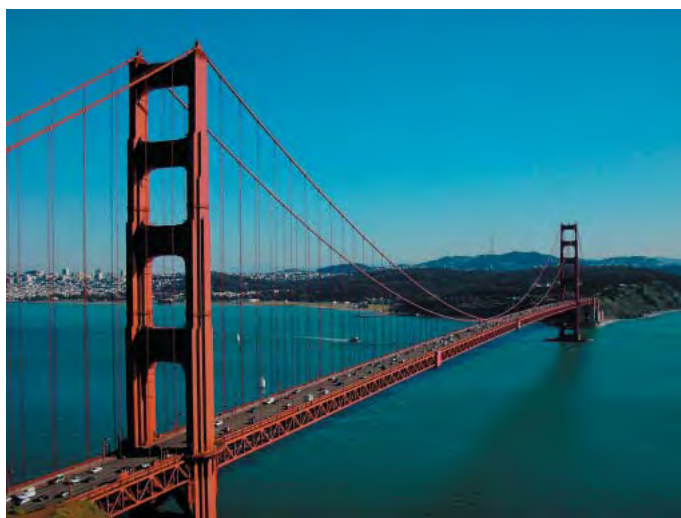
Figuur 2- Aanzicht brug
