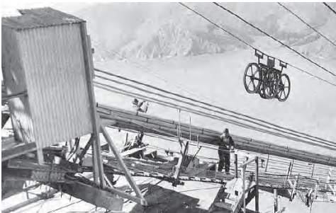
Figuur 3 - Bouw brug
