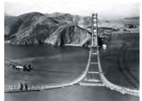
Figuur 5 - Bouw brug
