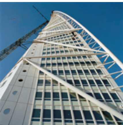
Figuur 5: Stalen constructie en gevel
