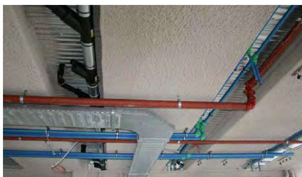
Figuur 1: Open ruimte faciliteert integratie van leidingen in vloerpakket
